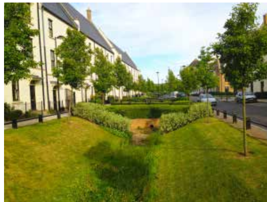
The swales within the development/ Болота в пределах застройки
