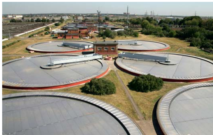
ПЕРЕКРЫТЫЕ ПЕРВИЧНЫЕ ОТСТОЙНИКИ
