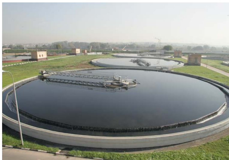
Вторичный отстойник блока удаления биогенных элементов
