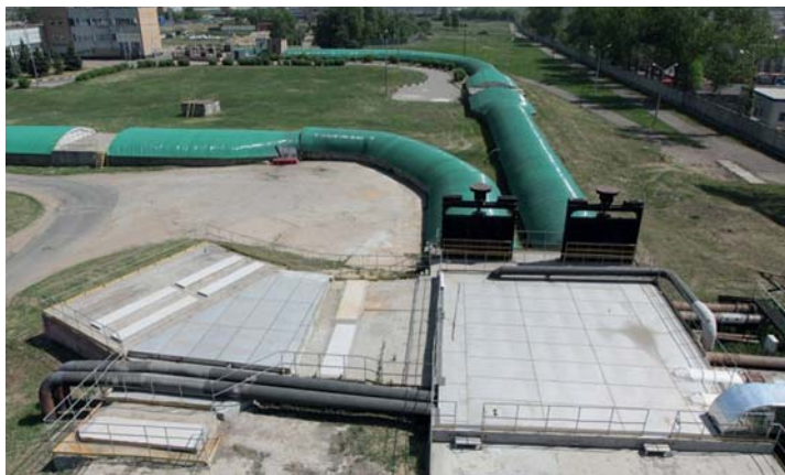
ПРИЕМНАЯ КАМЕРА ЛОС и подводящие каналы к зданиям решеток (полностью перекрыты)
