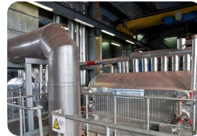
ЗСО на Юго-Западных очистных сооружениях (ЮЗОС) запущен в 2007 году Проектная производительность – 88 тонн сух. в-ва/сут.
