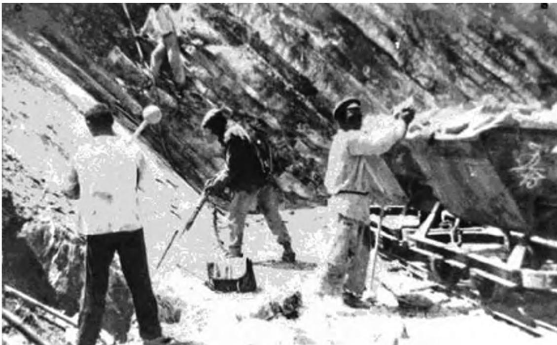
Рис. 12.15. Добыча мергеля в карьере ручным способом, 1929 г.
