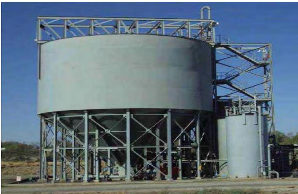
Рис. 16.7. Общий вид пастового сгустителя
