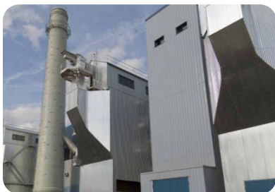
Завод на Центральной станции аэрации (ЦСА) запущен в 1997 году. Проектная производительность – 250 тонн сух. в-ва/сут.
